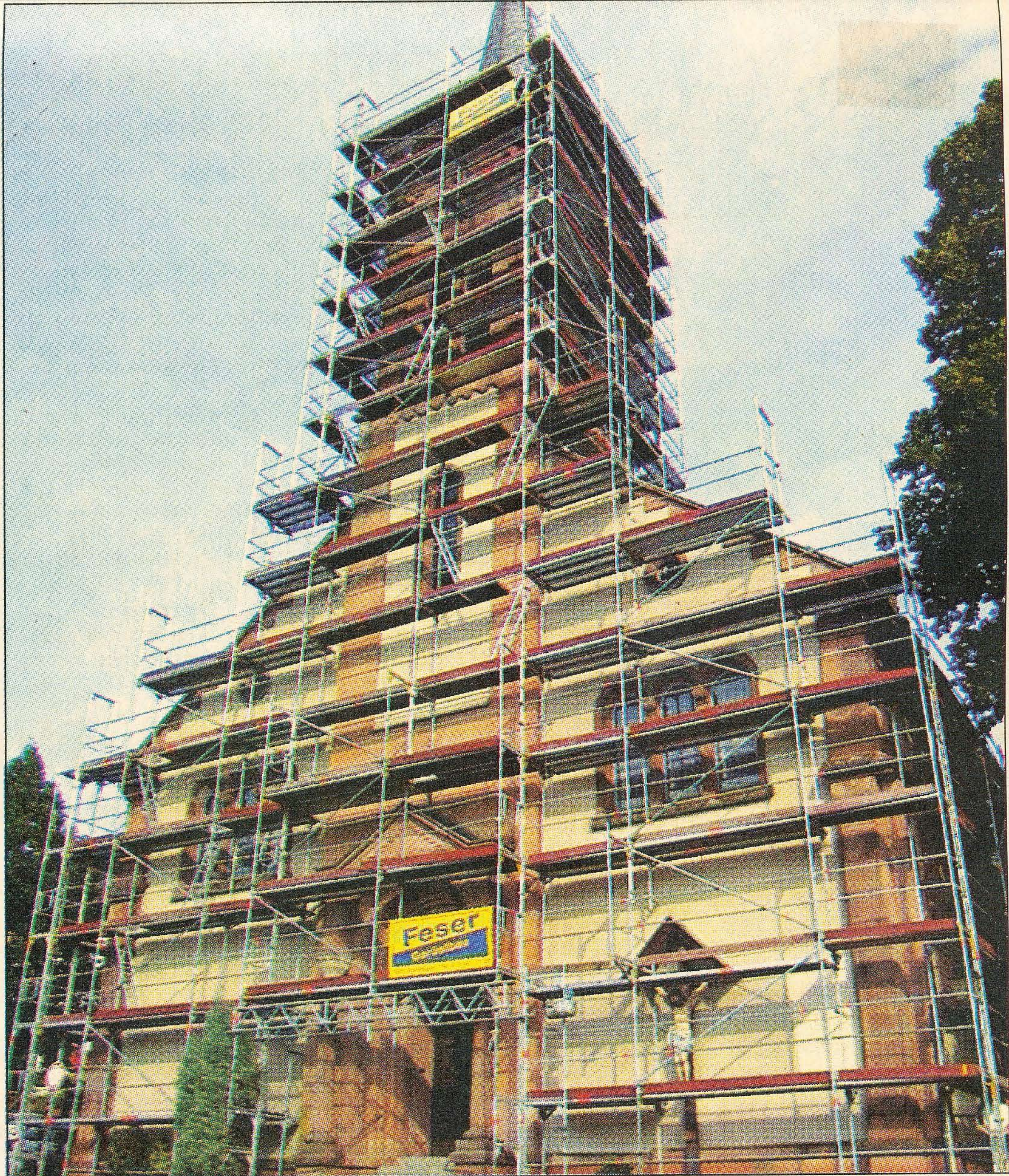
DRINGENDER HANDLUNGSBEDARF bestand bei der Sanierung des Turms der Dreifaltigkeitskirche. Die Maßnahme verschlingt 200 000 Euro. Fotos: esp
